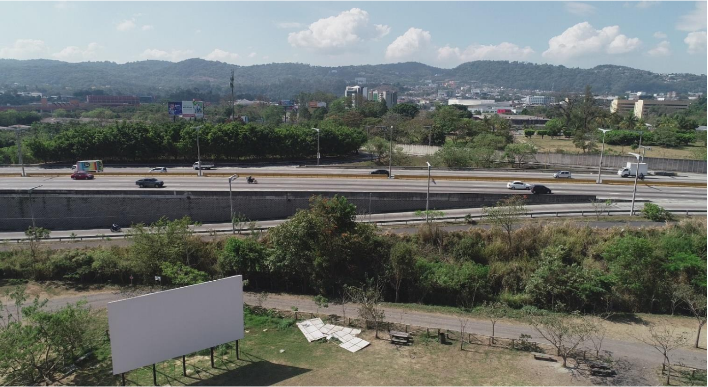
Figura 13. Vista dron Bulevar Monseñor Romero, marzo 2021. Fuente: visita de campo MARN 2021
